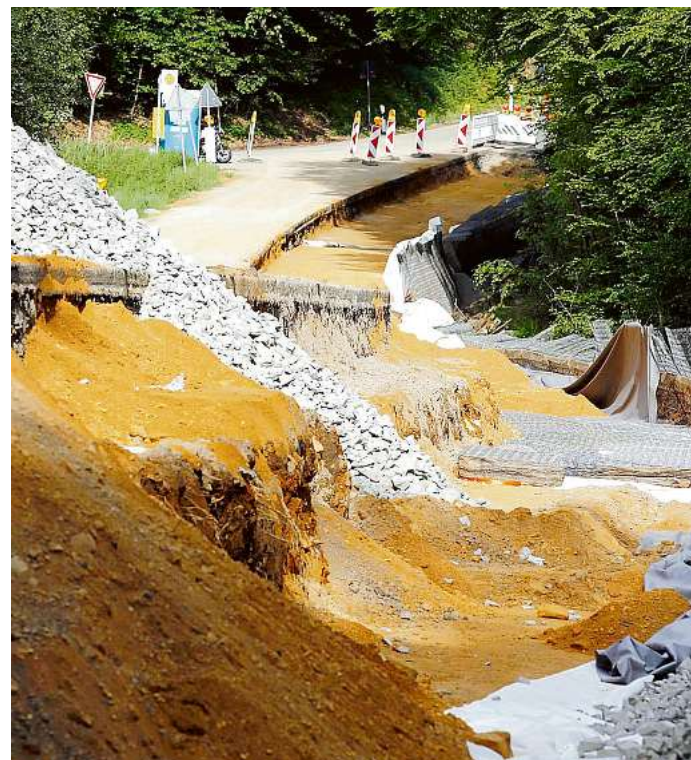
Blick auf die L 81: Sie wurde zwischen Einmündung in der Hardt und Mesenholl gesperrt. Der Hang drohte abzurutschen. Fotos: Roland Keusch
