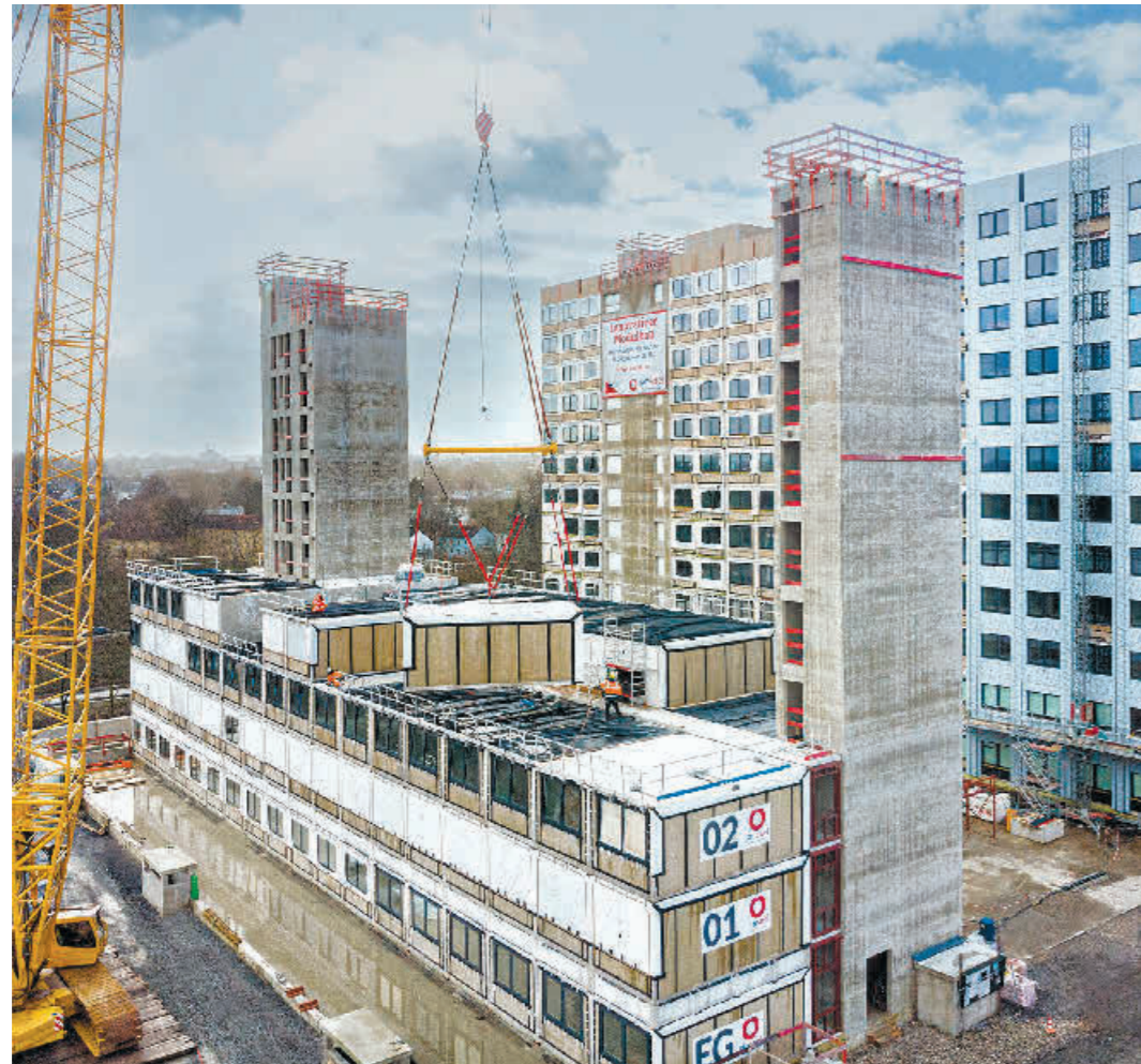
Europas höchstes Gebäude in modularer Bauweise: Das Studierendenwohnheim „Community Campus“ in Bochum hat zwölf Geschosse. Foto: Daiwa House Modular Europe
